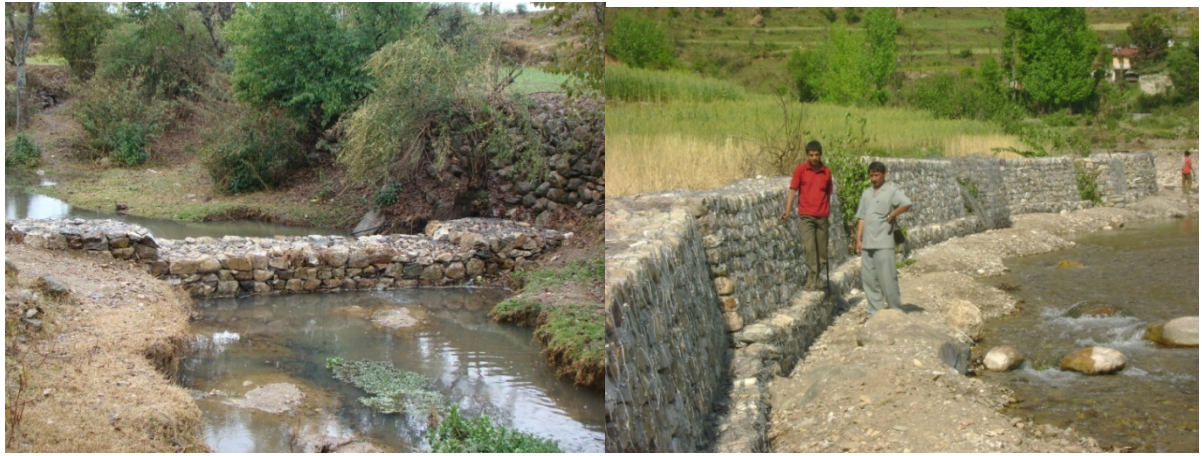
(d) Drainage Line Treatment (DLT) Works
